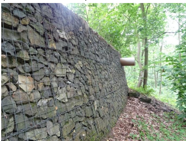
Vyústění odvodňovací roury
